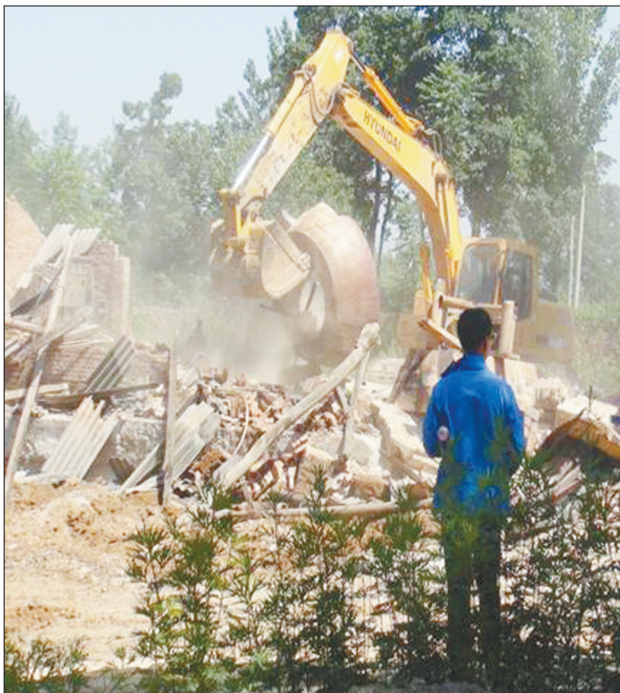
河南省三门峡市陕州区环保局近期持续加大对“散乱污”企业取缔力度。图为陕州区环保局取缔菜园乡过村黄金“三小”(混录碾)现场。 赵岩摄
