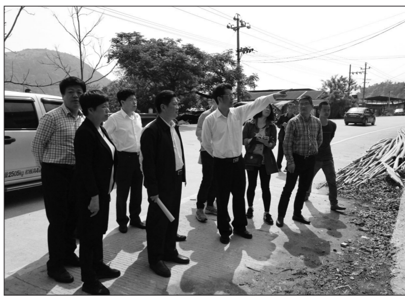
宁德市市长郭锡文(左五)赴福安市,现场察看后大村违法瓦窑加工厂拆除情况。
