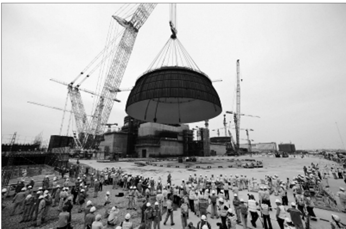
图为福清核电5号机组在进行穹顶吊装。
