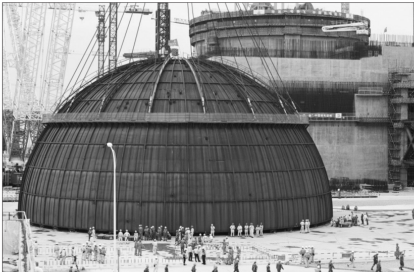
“华龙一号”全球首堆的穹顶是一个直径46.8米,重约340吨的半球体,加上沿海大风的影响,要将这样一个庞然大物精准安装到45米高的反应堆厂房上,难度可想而知。
