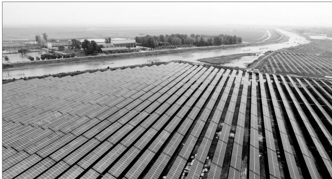
安徽省庐江县近年来利用湿地水面、荒山坡地大力发展光伏产业。截至目前,庐江县电网6座110千伏、15座35千伏变电站均具备新能源并网接入条件,年消纳清洁光伏发电达1074万千瓦时,年均减少使用标准煤4000多吨,减少二氧化碳排量1万余吨。
