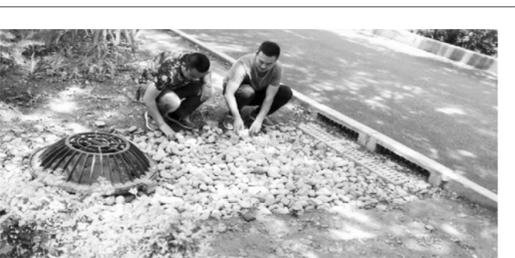
陕西省宝鸡市为消除路面积水现象,按照海绵城市建设的要求,探索出一种新的方案,即通过将慢车道道沿每隔40米砌筑侧式排水沟,路缘石后绿化带中设拦污筐,用于分离垃圾杂物。雨水通过拦污筐、卵石过滤净化后流入渗水井,再渗入地下。这一模式将“渗、滞、蓄、净、用、排”有机结合,可最大程度减少城镇化发展建设对原自然水特征和水生态环境带来的负面影响,从而实现对雨水的自然积存、自然渗透、自然净化。 仵博摄
