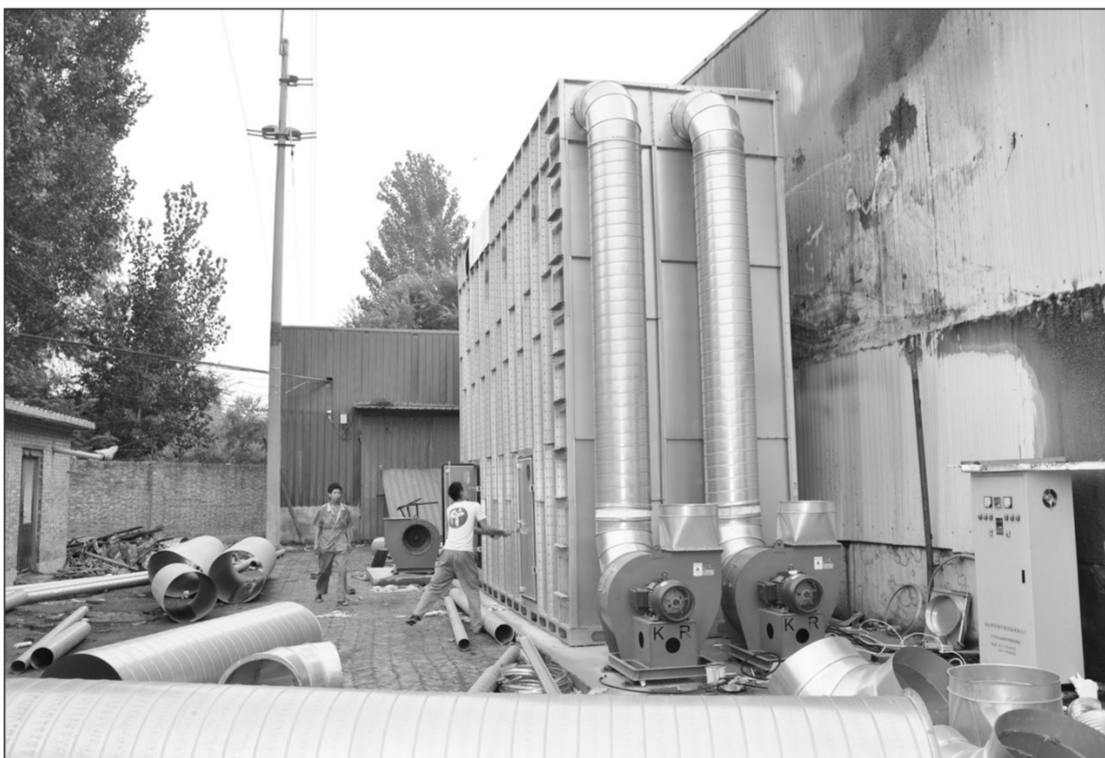
山东德州积极抓住环保督查机遇,督导解决“散乱污”等突出环境问题,不仅消除了大量散乱污染源,还有效推动了传统行业的提档升级。图为德州恒岳家具厂正在安装中央脉冲除尘设备,设施运行董若义摄
