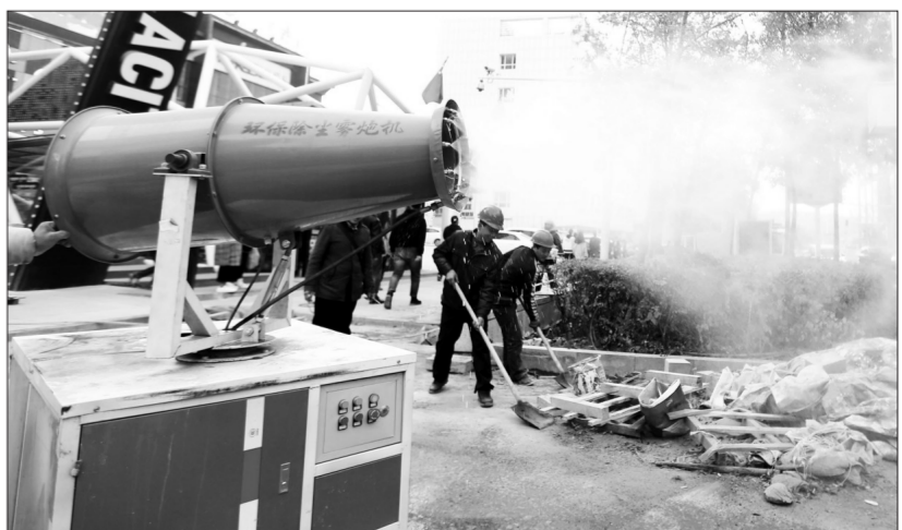
在新疆维吾尔自治区乌鲁木齐市天山区绿化工程第五标段施工工地,新型移动式除尘装备“环保除尘雾炮机”正在降尘。据悉,在乌鲁木齐市市政工地及建筑工地都配有雾炮机等降尘设备,缓解了大气环境污染状况,受到市民赞誉。
