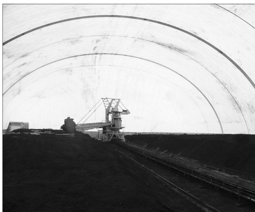
本月中旬,河北省邢台国泰发电公司煤场封闭工程最后一块屋面铝板安装完成,标志着煤场封闭主体工程竣工。后续消防系统、监测系统、喷淋系统、外部环境绿化等配套工作正在紧张进行。工程竣工后可实现存煤23万吨,满足两台30万千瓦机组燃煤需求。不仅可以有效减少燃煤损失,还能消除燃煤粉尘外溢对环境的影响。图为邢台国泰发电公司煤场封闭主体工程。
