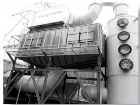
图为投料打磨粉尘处理-陕西有色天宏新材料有限公司。
