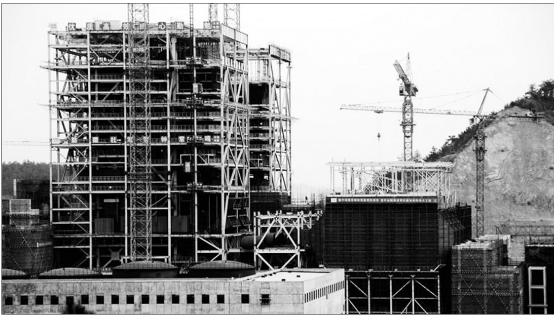
湖北省十堰市京能热电厂1号机组除尘设备安装主体工程近日正式封顶。京能十堰热电厂项目是南水北调中线核心水源区配套设施项目和京津地区对口协作示范项目,项目建成后,可淘汰、关闭城区的两个小热发电机组和区域内87台燃煤小锅炉,每年可实现区域内减排二氧化硫8516吨,减排粉尘4.8万吨,减排氮氧化物9954吨。
