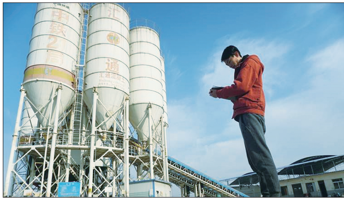
陕西省渭南市近日按照《渭南市2017年铁腕治霾冬防攻坚行动巡查执法方案》对相关县市区冬防工作开展巡查督办，重点对企业“一厂一档”“一厂一案”“一厂一策”“二维码管理”等环境监管“四项机制”落实情况进行现场检查督办。针对存在的问题，巡查办将巡查情况汇总后向各相关县市区进行通报。 仵博摄
