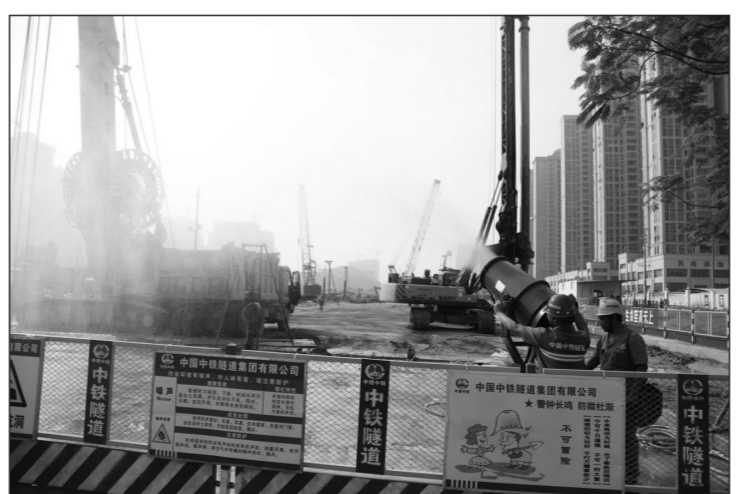
南宁地铁3号线实施喷淋降尘作业,减轻扬尘污染。彭威摄
