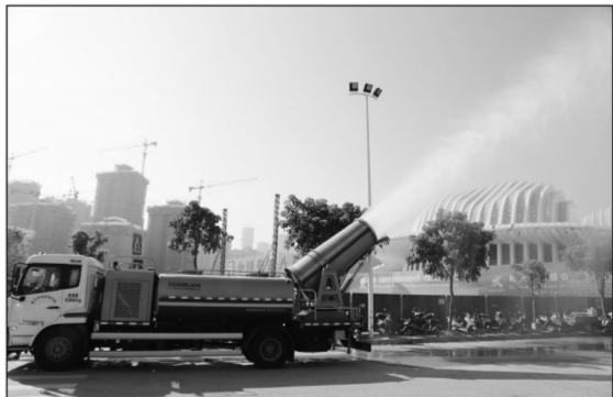
南宁市五象新区工地正在实施降尘作业。彭威摄
