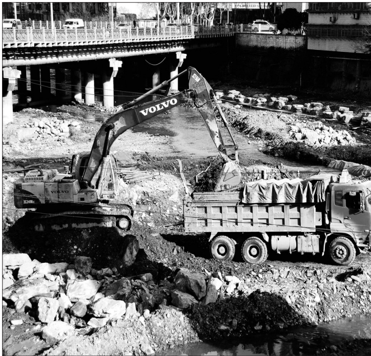
在湖北省十堰市茅箭区马家河武当路街办段河道综合治理工程施工现场,多台大型设备正在清除淤泥垃圾、开挖河槽。同时,当地采用生态防护措施,增设绿化、景观节点、自行车道、景观基础配套设施等。 人民图片网供图/薛乐生摄
