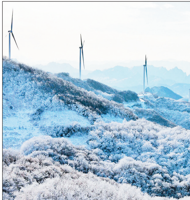
湖北省保康县后坪镇黄连山风力发电场 24 台风力发电机组近日投入运营,年上网电量达 8280 万千瓦时,每年可节约标煤 35 万吨,减少排放量 6000 吨、二氧化碳 150 万吨、二氧化硫 5000 吨。图为风力发电机矗立在后坪镇的群山之中。人民图片网供图
