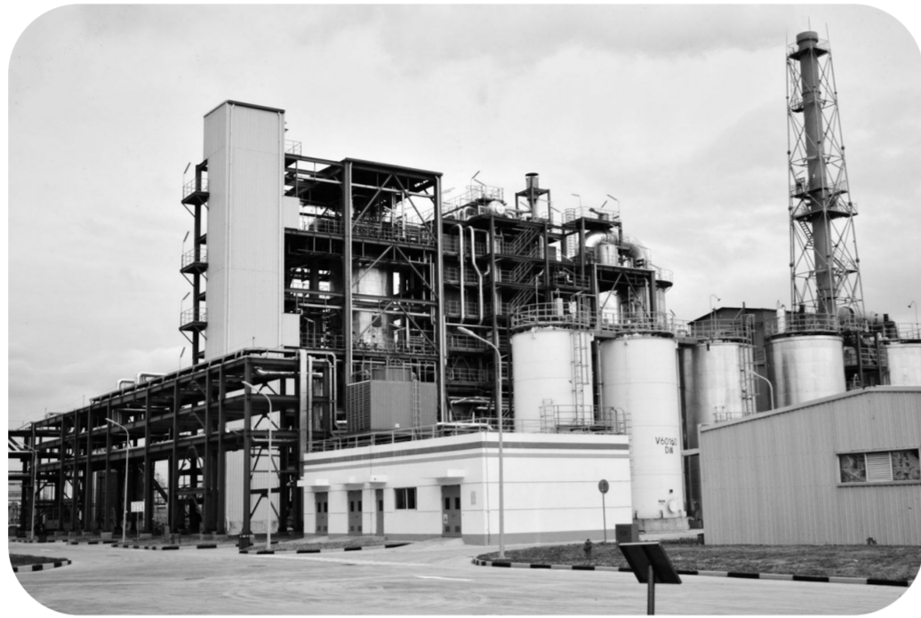
苏伊士上海化工区的危废处置厂第三条生产线去年投入运营。资料图片
