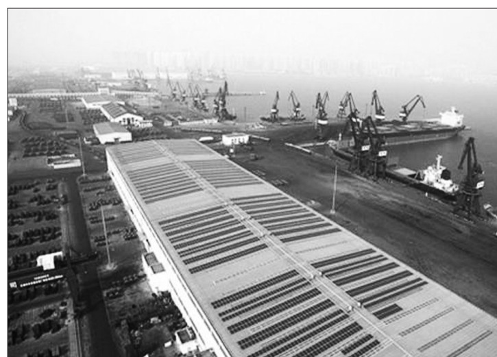
大连港集团开发建设的包括分布式光伏发电项目等21个绿色节能环保港口主题项目,近日通过专家审核验收,大连港成为全国节能减排主题试点港口。 付磊摄
