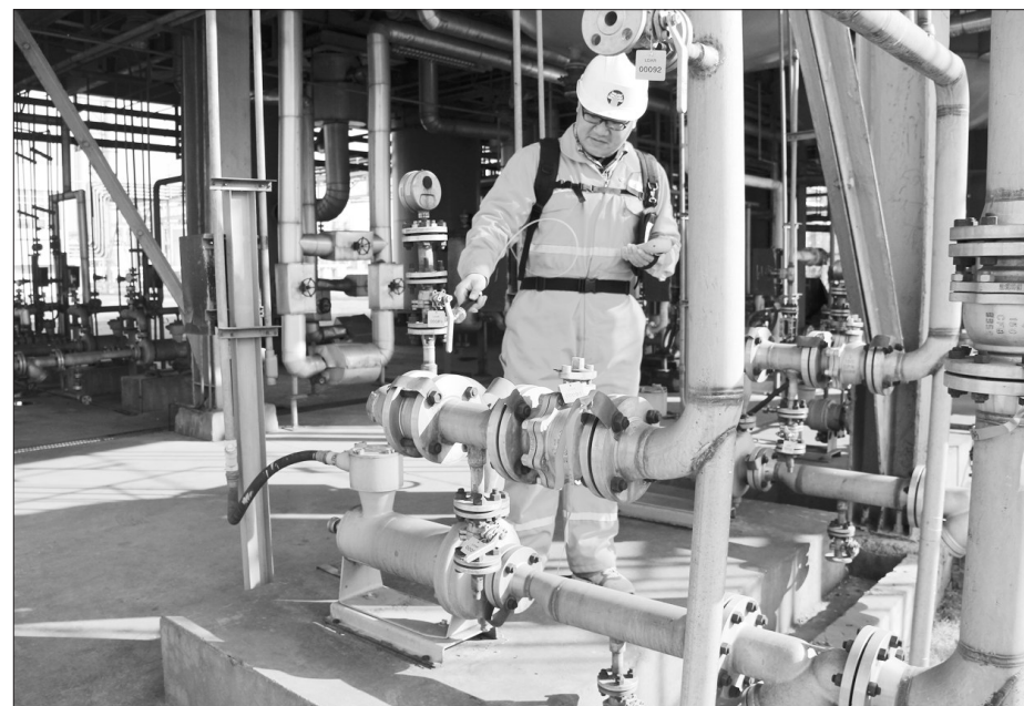
浙江省嘉兴港区34家涉LDAR(泄漏检测与修复)企业泄漏检测工作近期顺利收官。34家企业共有建档点位29万余个,完成率98.51%;第三方检测机构全年累计检测57万点次,共发现泄漏点4931点次,泄漏率仅0.857%。
