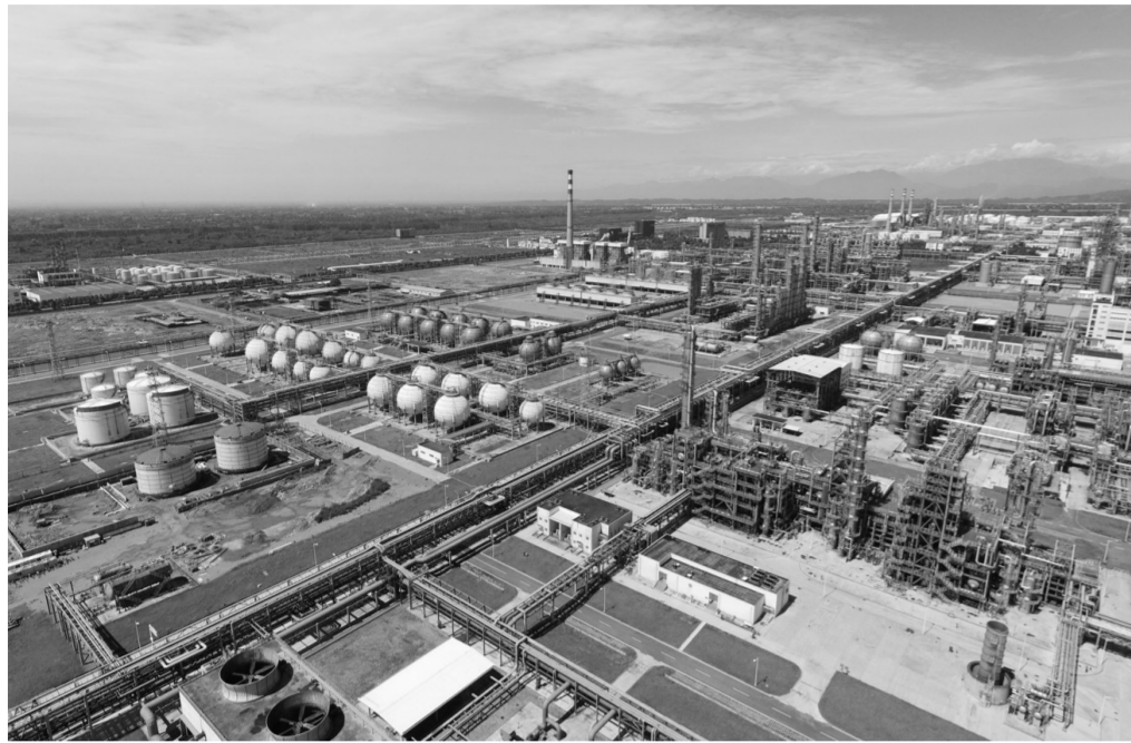
图为坐落在四川省彭州市的中石油四川石化有限责任公司厂区
