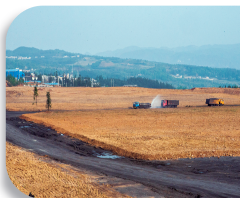
复垦工作严格按照不同物质进行分层回填
