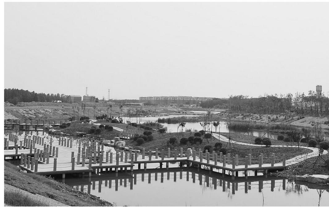
图为孝妇河人工湿地工程。
