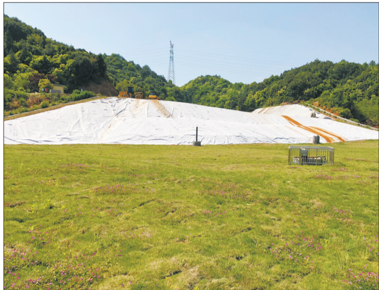
图为景德镇市浮梁县三龙垃圾发电厂整改现场。本报记者谢佳沅摄
