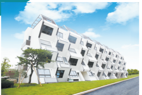
粉墙黛瓦——吴江中达低碳示范住宅
