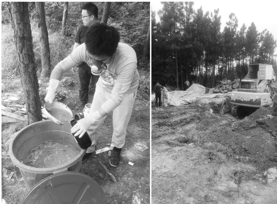
左图为现场采样监测,右图为挖掘现场。
