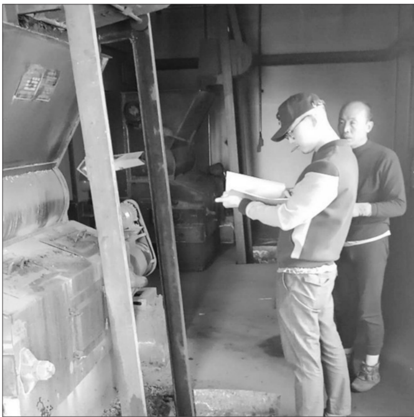
时间:2018年3月27日 地点:京新高速公路临白段黑崖山服务区锅炉房(距额济纳旗达来呼鲁镇300多公里)
