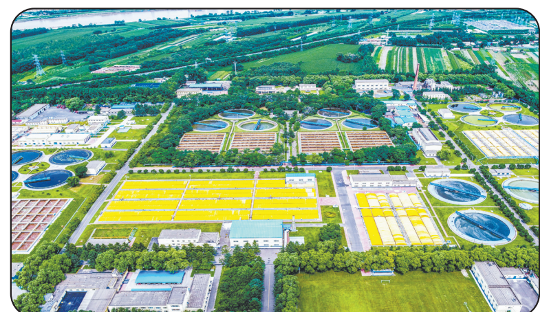
改造后的吉林石化公司污水处理厂。
