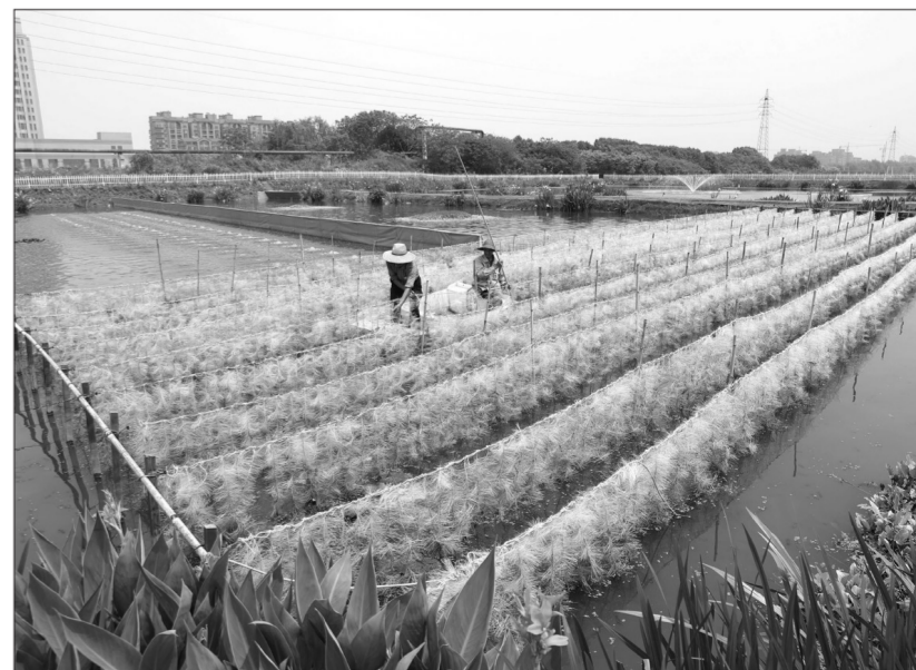
德清县是浙江省淡水渔业重点县,通过分类采取规范场自治和散户连片养殖集中式治理两种形式,建设了养殖尾水处理设施系统,实现循环水再利用和达标排放。
