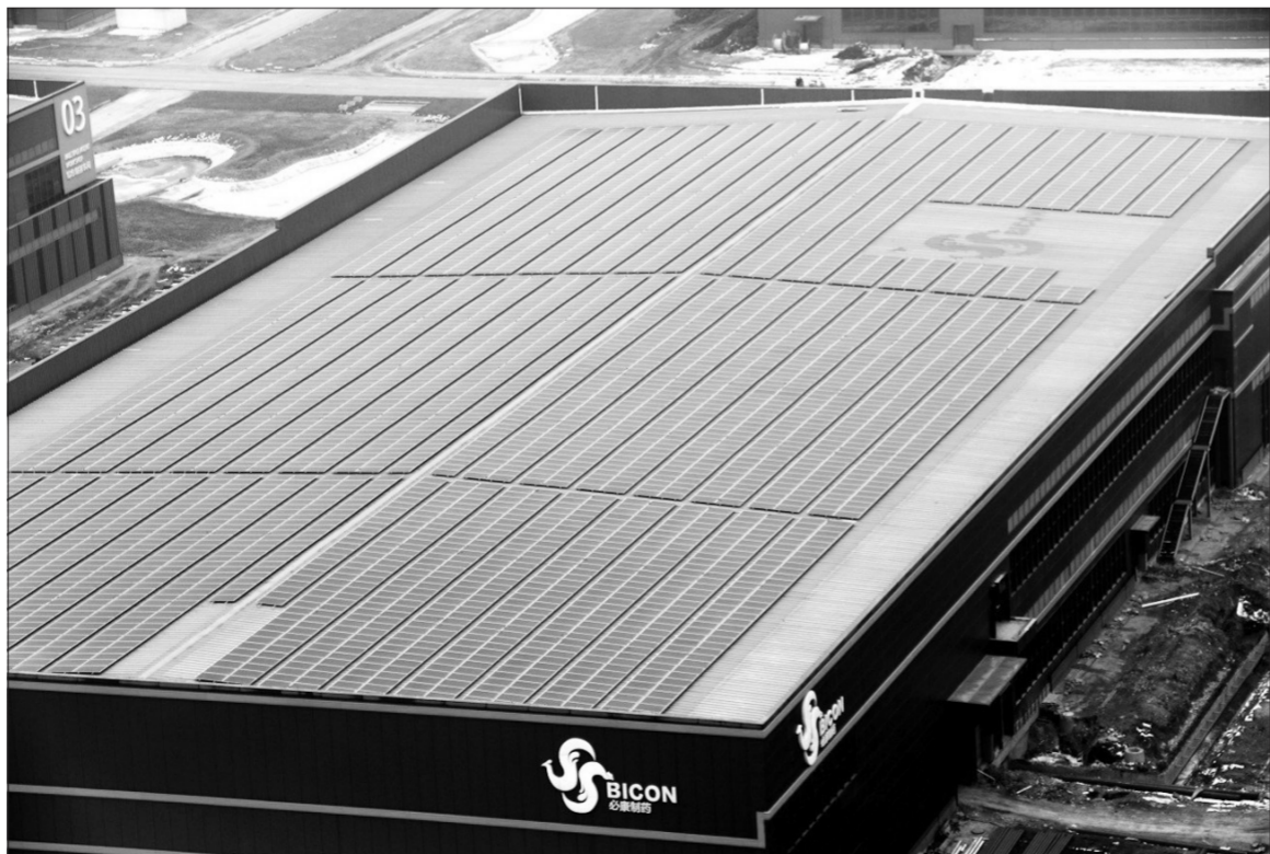
江苏省徐州市新沂永辉光伏科技有限公司绿色屋顶能源一体化项目(简称项目)近期完成安装,部分光伏板开始组网。
