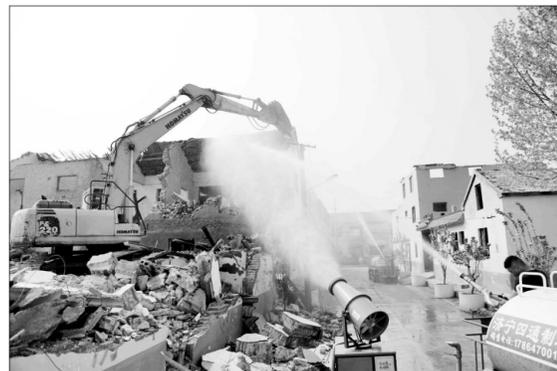
为改善环境空气质量,山东省济宁市任城区环保局联合住建部门组织拆迁公司签订防尘承诺书,通过房屋渗透、高压喷水、架设围挡、
