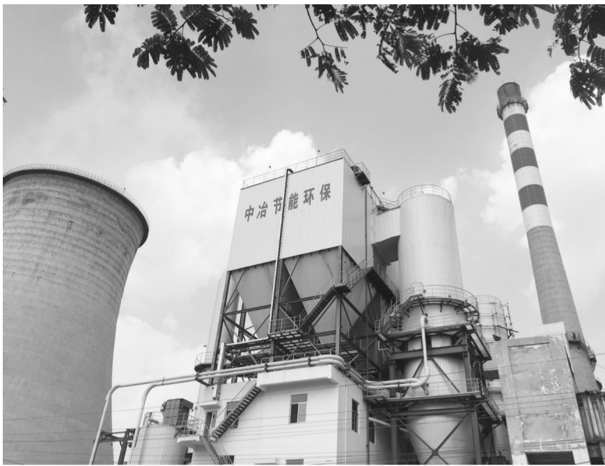
兖矿南屯电力3×220t/h锅炉烟气处理排放工程
