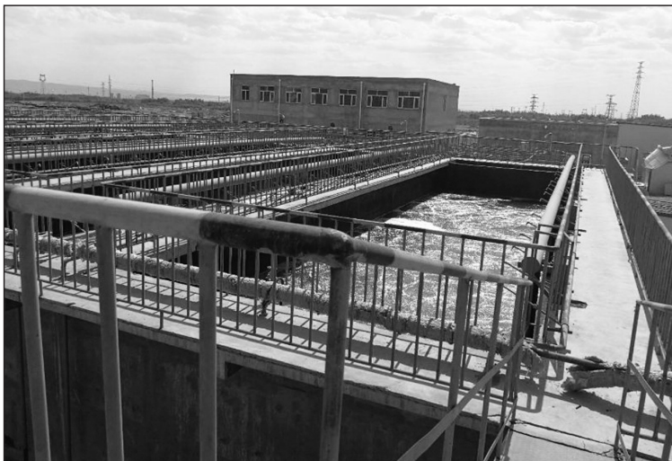
图为现场检查时生化废水处理站正在调试。 本报记者邢飞龙摄
