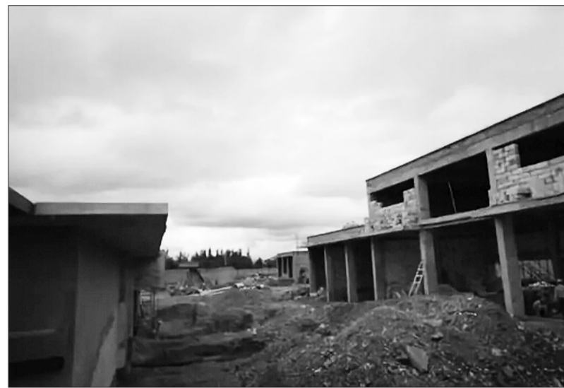
通海县第二污水处理厂工程进度缓慢。
