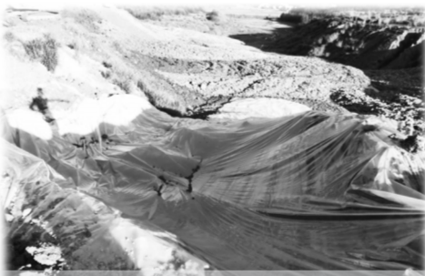
对已倾倒的酸渣进行覆膜,避免污染扩散。
