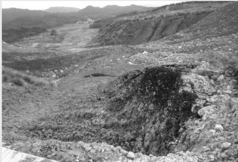
图为倾倒酸渣现场。
