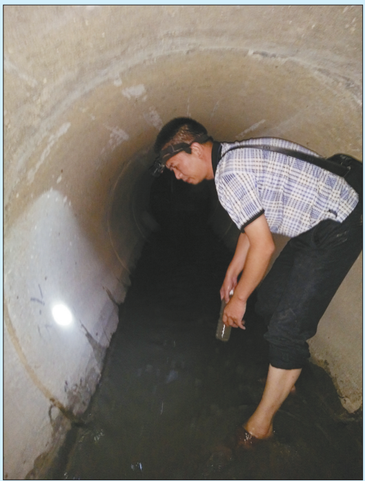
福建省环境监察总队执法人员在水泥涵洞内循着污水勘查企业排污管。
