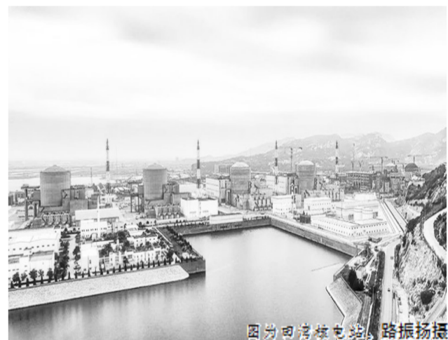
图为田湾核电站,路振扬摄
