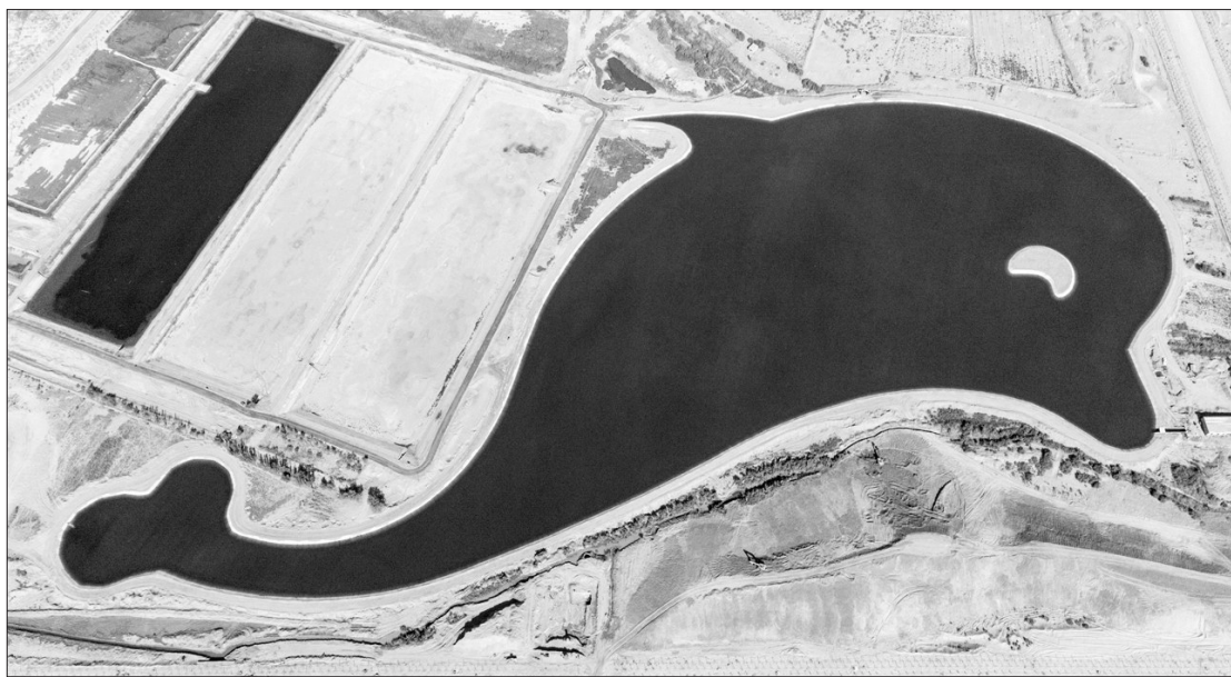
新疆维吾尔自治区尉犁县污水处理生态回用尾水库工程近日正式进水运行,“小海豚”生态回用尾水库成为环保景观。这一工程可满足该县达西工业园区约1万亩绿化用水需求,将大大提高城镇生活污水的再处理、再利用能力。 人民图片网供图
