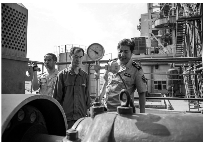
山东省潍坊市为改善环境质量,不断加大环境监管执法力度,强化工业企业排放控制管理。图为环境执法人员在企业开展现场检查。孙鹏摄
