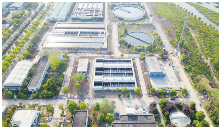
图为白洋淀中村污水深度脱氮示范项目。资料图片
