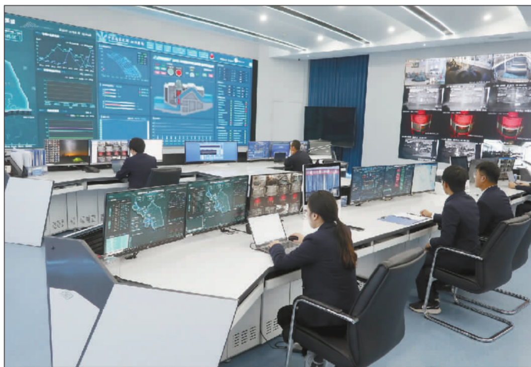
中国南水北调集团日前透露,截至3月18日14时,南水北调东中线一期工程累计调水突破700亿立方米,沿线7省市1.76亿人从中受益。近年来,中国南水北调集团坚持创新驱动,大力推进数字南水北调和水网智能化建设,加快发展新质生产力,初步构建起具有预报、预警、预演、预案“四预”功能的数字南水北调工程体系。图为南水北调江苏集中控制中心。
