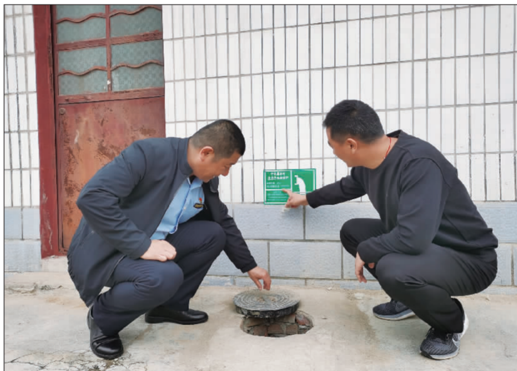
一段时间以来,山东省泰安市生态环境局宁阳分局坚持差异化治理模式,因地制宜持续推进农村生活污水治理,努力打造让群众满意的民心工程,助力乡村生态振兴。图为宁阳分局工作人员现场检查污水收集治理设施运行状况。董若义 秦冰摄影报道
